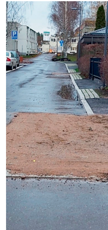
Kisapolku 15.11.2022 katusaneerauksen jälkeen. Juholankadun jalkakäytävä avattu uudelleen, jäänyt asfaltoimatta.
